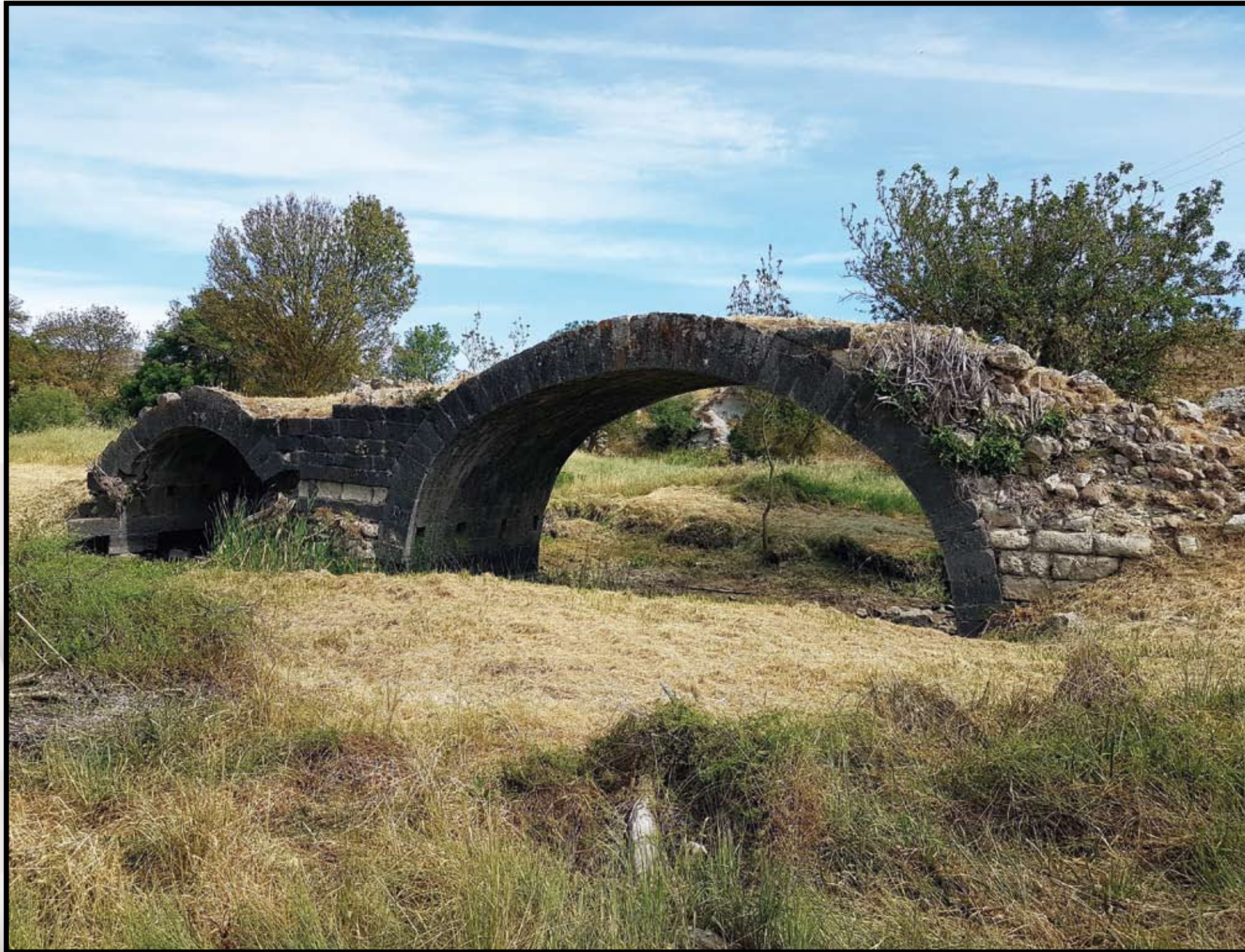
Ittireddu, Pont'Ezzu (I° secolo d.C.)
